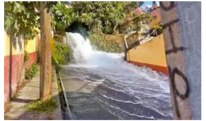
Una falla en el mecanismo de elevación de la compuerta de la trifurcación Judío-Lerma generó aguas broncas.
